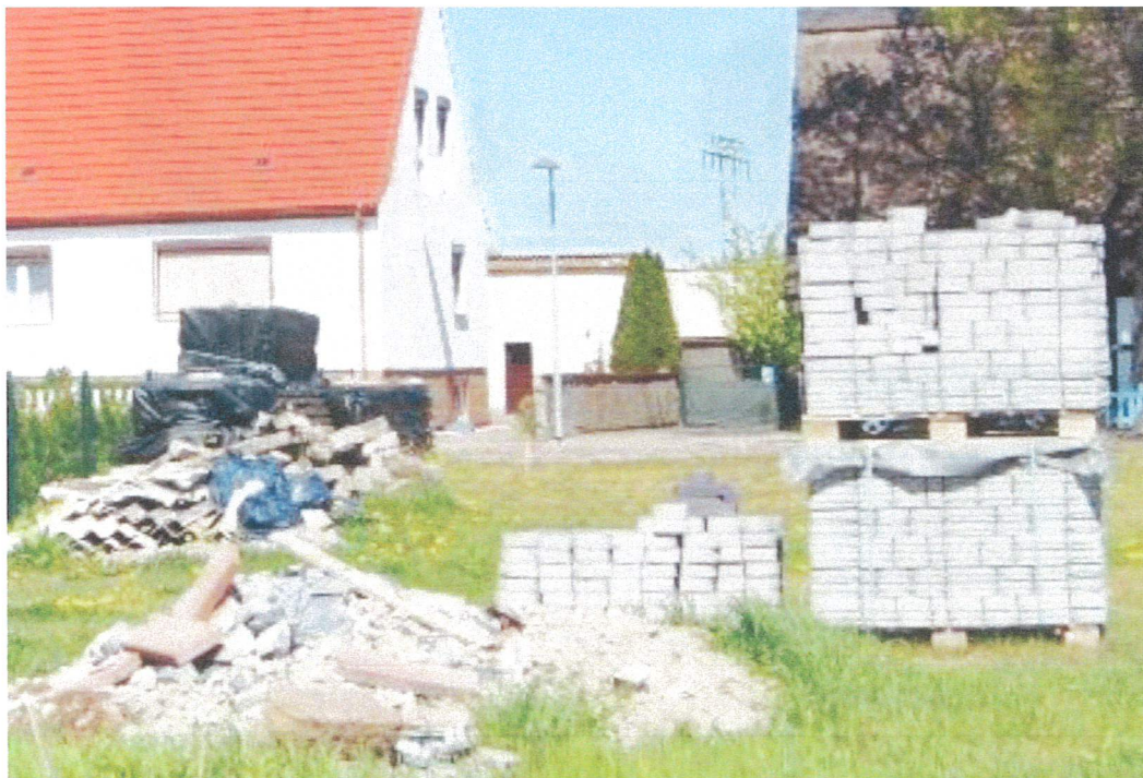
Bild 06 an der südlichen Plangebietsgrenze: Bauschutt
